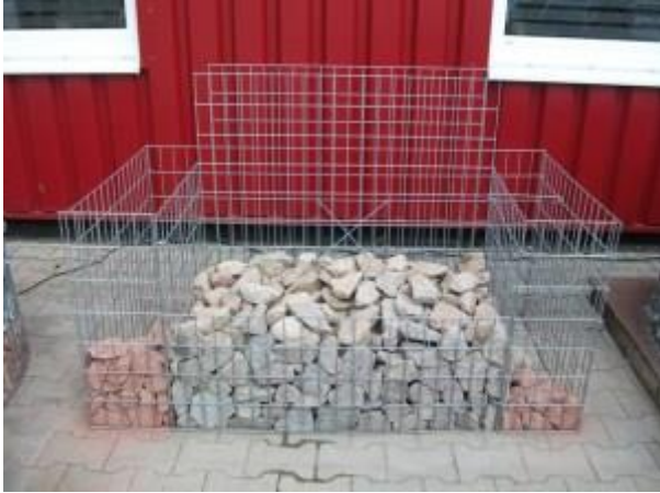
Befüllung mit Steine
